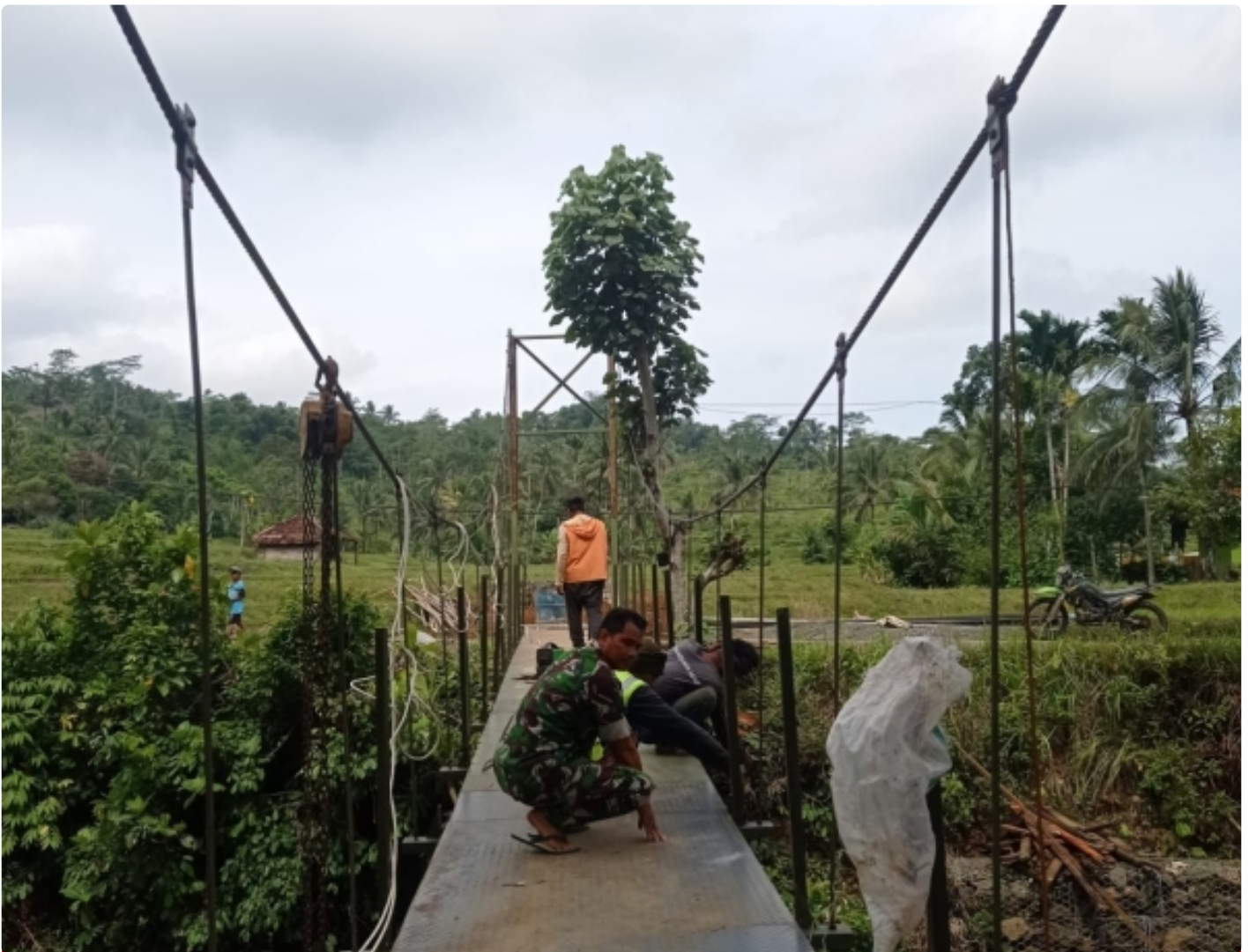
Kpt Arm Witono: Pengerjaan Jembatan Gantung Sudah 80%
