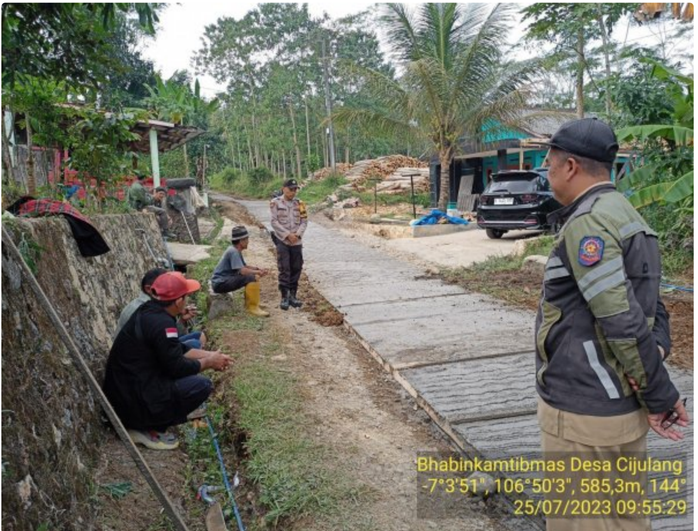
Aipda Sudiro Monitoring Pembangunan MCK di Desa
